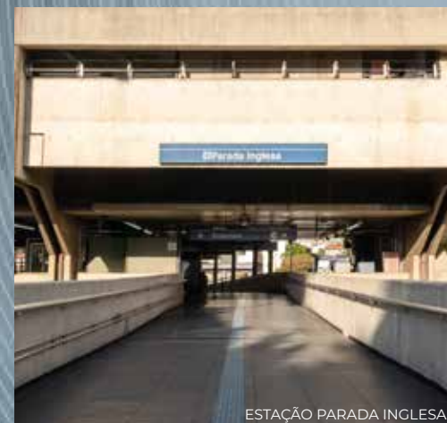
ESTAÇÃO PARADA INGLESIA
